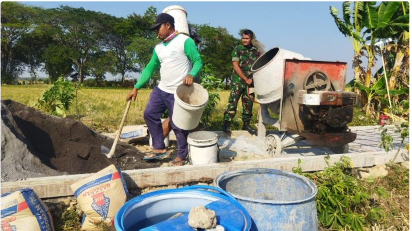
Menjadi Pelopor Diwilayah Binaan, Babinsa Gotong-Royong Bangun Jalan Desa.
