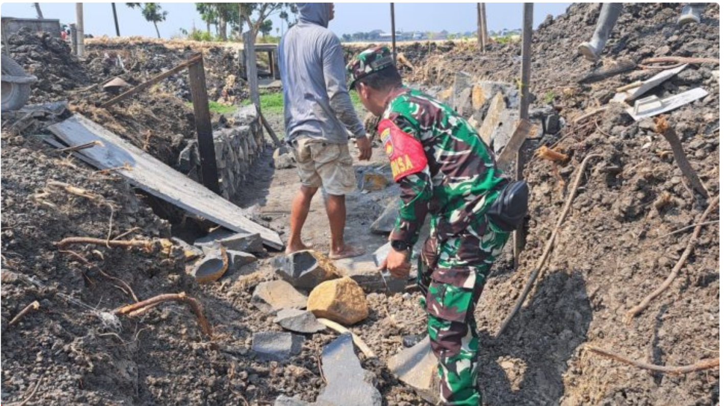
Bersama Warga, Babinsa Gotong Royong Bangun Talud Irigasi.
